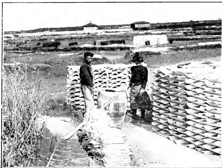
FIG. 10.—LIMING TILES, LA TESTE, ARCACHON.
